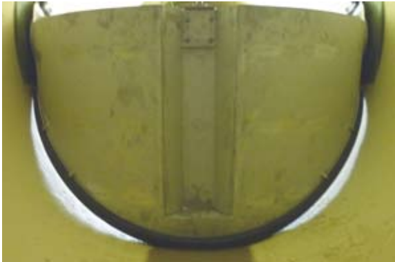
Bild 5 Bogenklappe nach Einbau in höhenmäßig deformiertes Rohr
