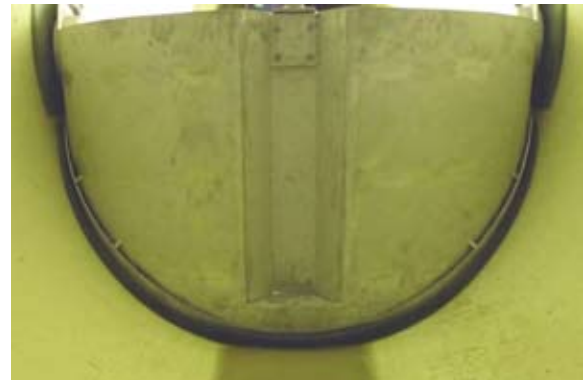
Bild 6 Bogenklappe nach Einstellung des Dichtungssystems
